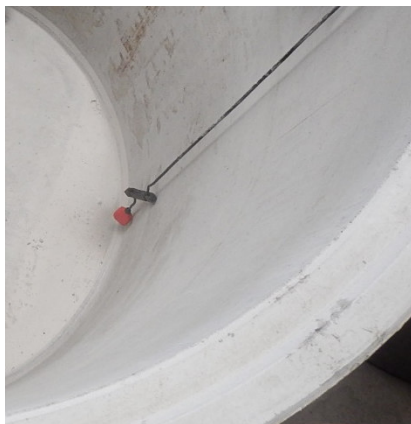
Bild 4: Einbau Schwimmer S2
